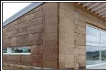
Il sughero da facciata: in pannelli per cappotto, in granuli per riempimento, in lastre sottopavimento
